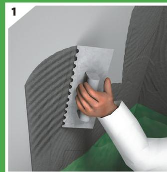
Breng flexlijm\* aan op een zuivere ondergrond met een lijmkam (vertanding 3x3 mm)
