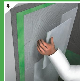
Laat alles minimum 24 uur drogen voordat u uw tegels begint te plaatsen. Gebruik voor de plaatsing van uw tegels uitsluitend flex-tegel-lijm.\*
