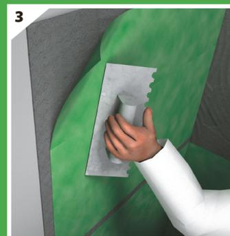
Druk de Greenlooxmat aan met de vlakke zijde van de lijmkam. Vermijd luchtballen.
